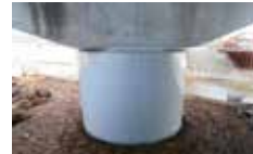
橋脚耐震補強工事
