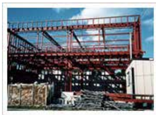
新築事務所鉄骨工事
