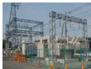
特高トランス更新工事
