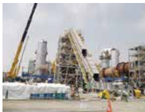
プラント据付工事
