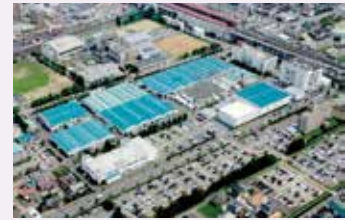
古川工場全景
