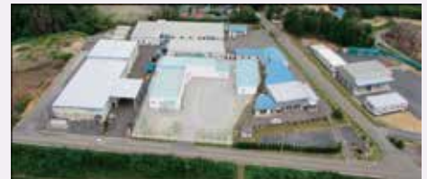
本社工場全景
