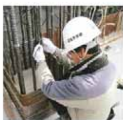
鉄筋継手部検査
