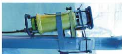
配管の放射線検査
