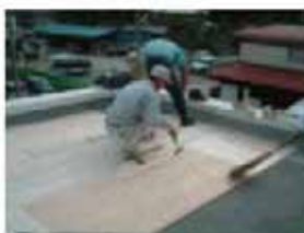
屋上防水改修工事
