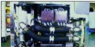
配管・配線組立
