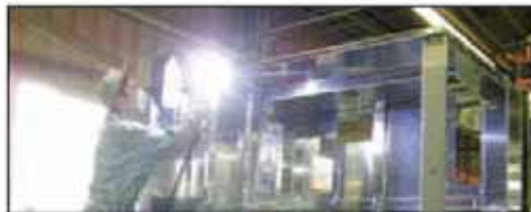
資格認定者による溶接作業
