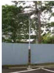
太陽光パネル防犯灯
