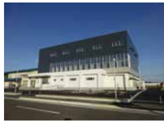
体育館電気設備工事
