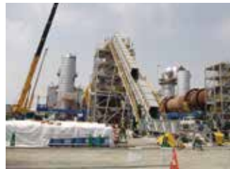
プラント据付工事
