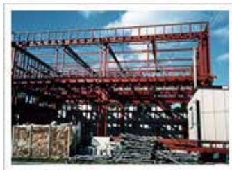
新築事務所鉄骨工事
