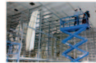
原状回復工事
