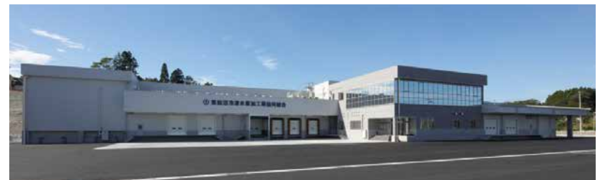
気仙沼冷凍水産加工業協同組合本部事務所・HACCP 対応冷凍冷蔵施設・保税蔵置場
