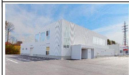
新本社工場(黒川郡大和町)外観
