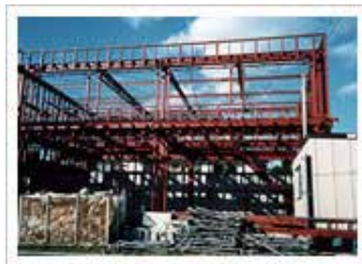
新築事務所鉄骨工事
