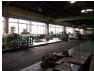
工場内組立場
