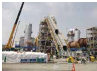
プラント据付工事
