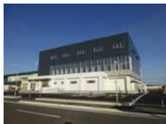
体育館電気設備工事
