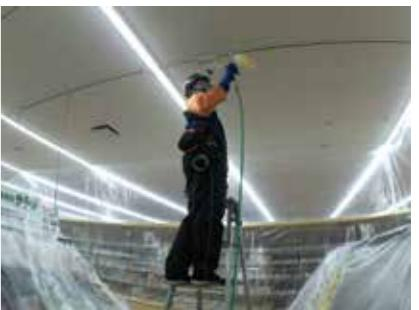
「アドバンスコート」の施工現場。低圧スプレーガンで1m<sup>2</sup>20~30ccを噴霧する
