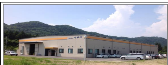
〔震災後 高台に新設した仙台名取工場〕
