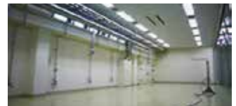
【振動防振床・温湿度管理を導入した加工エリア】
