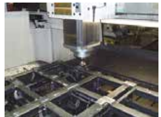
【架台二次加工の様子】
