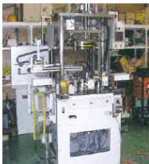
【客先既存設備の改造・ 更新】 新規生産品の為の機械 改造・制御盤更新・PC 更新など
