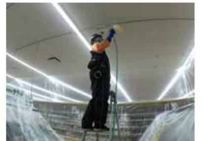
「アドバンスコート」の施工現場。低圧スプレーガンで1m<sup>2</sup>20~30ccを噴霧する
