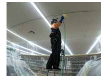
「アドバンスコート」の施工現場。低圧スプレーガンで1m 2 20~30ccを噴霧する
