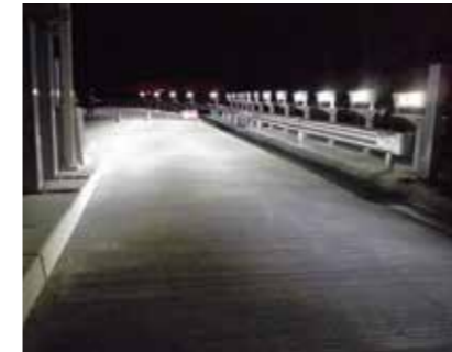
三陸自動車道多賀城I.C.に採用。該当車線以外への漏れ光も少なく、路面全体を明るく照らし出す
